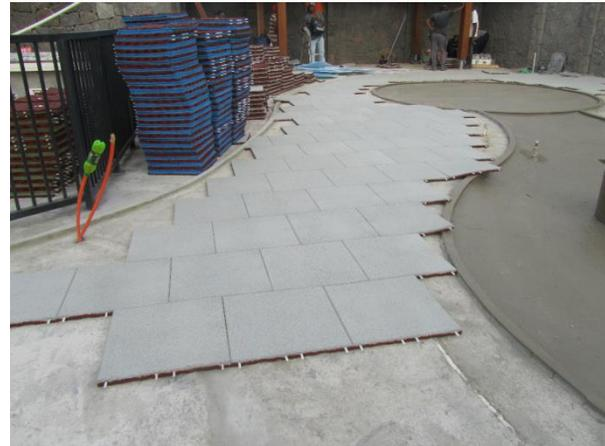
Die Platten müssen formschlüssig ohne Fugenbildung verlegt werden.
