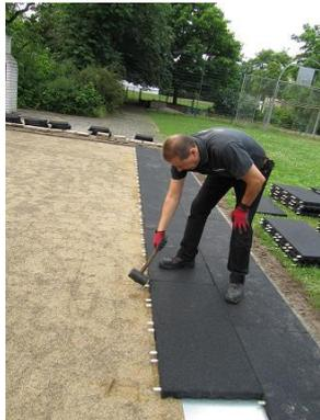
Die Platten der ersten und letzten Reihe sowie alle Rand- bzw. Eckprofile können untereinander sowie mit der Flächenbegrenzung bzw. Kanteneinfassung verklebt werden, um die Platten gegen unbefugtes Entfernen zu sichern.
