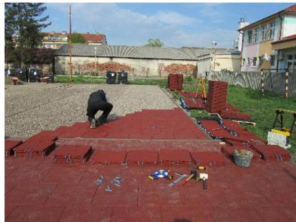
Das Verlegen von Ballspielflächen sollte so erfolgen, dass die Spielrichtung entgegen der Steckverbindung verläuft.
