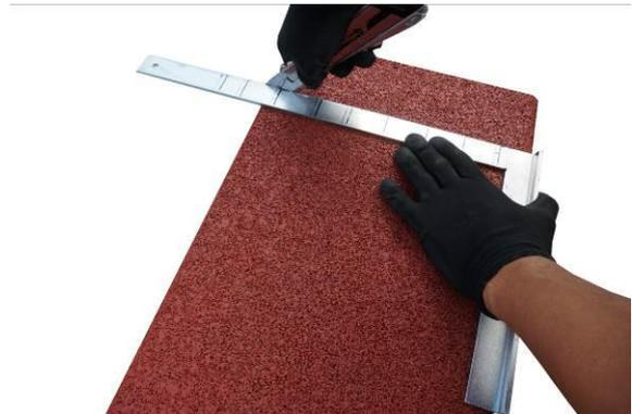
**markieren Sie die Schnittstelle und achten Sie darauf, dass der Schnitt gerade verläuft.**
